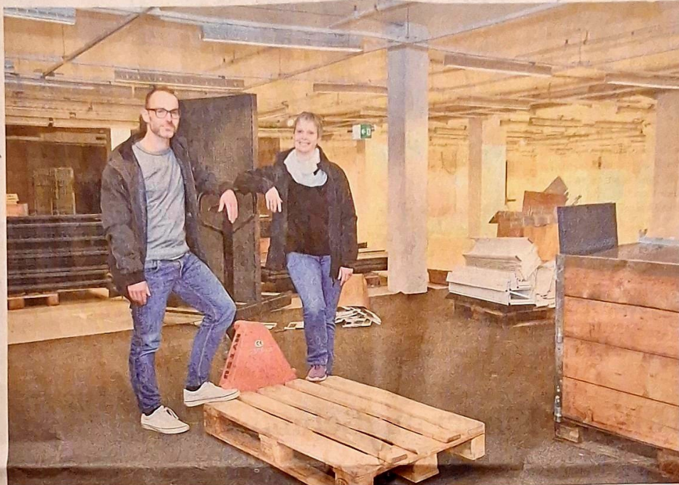
Adrian Scherrer und Ranya Lanig in den ehemaligen Räumlichkeiten des Do it + Garden Migros. Der Umbau hat gestartet. Bald ziehen hier Bibliothek und Ludothek ein. Bild: Corinne Hanselmann
